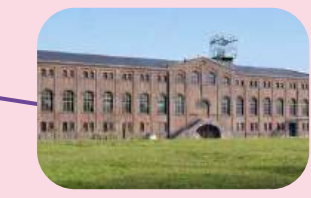
Maschinenhalle Zweckel Gladbeck
